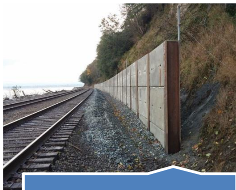
Τοίχοι αντιστήριξης από οπλισμένο σκυρόδεμα
