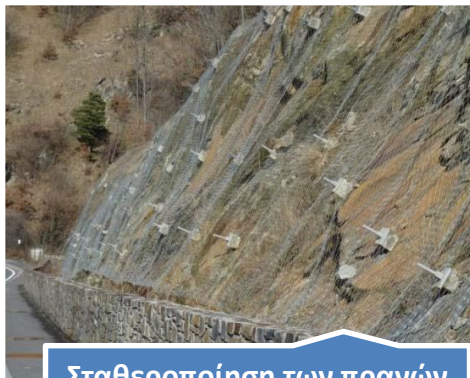
Σταθεροποίηση των πρανών με δίκτυ προστασίας και αγκύρια
